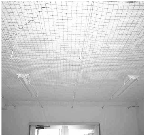
ネットとロープで天井下部より直接天井を保護する
